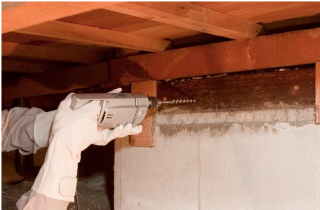
床下木部穿孔注入処理
