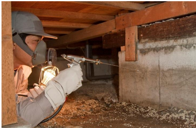
コンクリート散布処理
