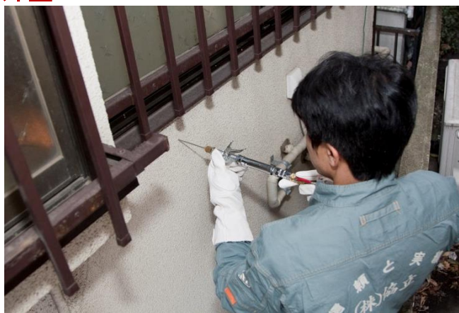
外壁穿孔注入処理
