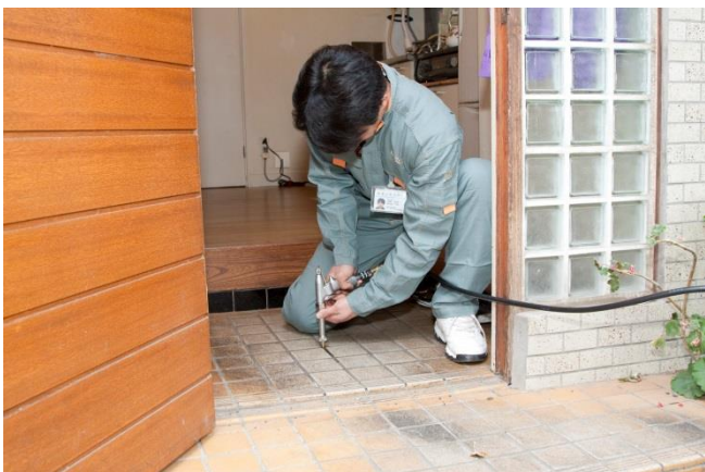
玄関タイル下土壌穿孔注入処理
