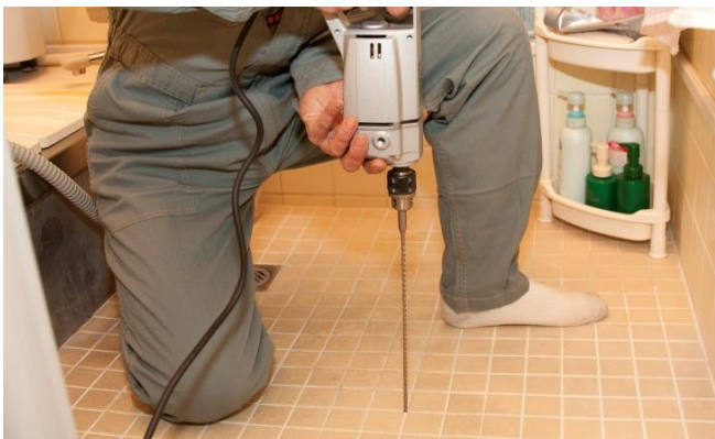
浴室床タイル穿孔注入処理
