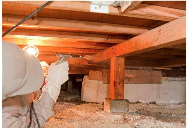
床下木部散布処理
