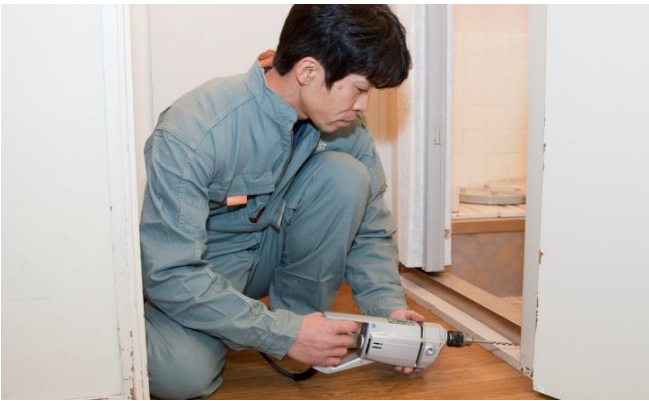
浴室出入口木部穿孔注入処理
